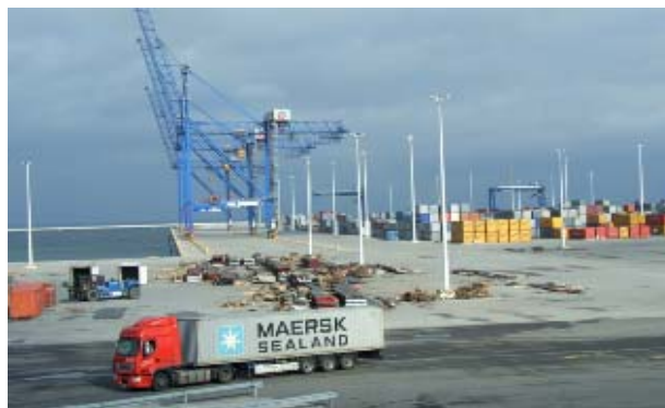
Głębokowodny Terminal Kontenerowy (DCT), Gdańsk
